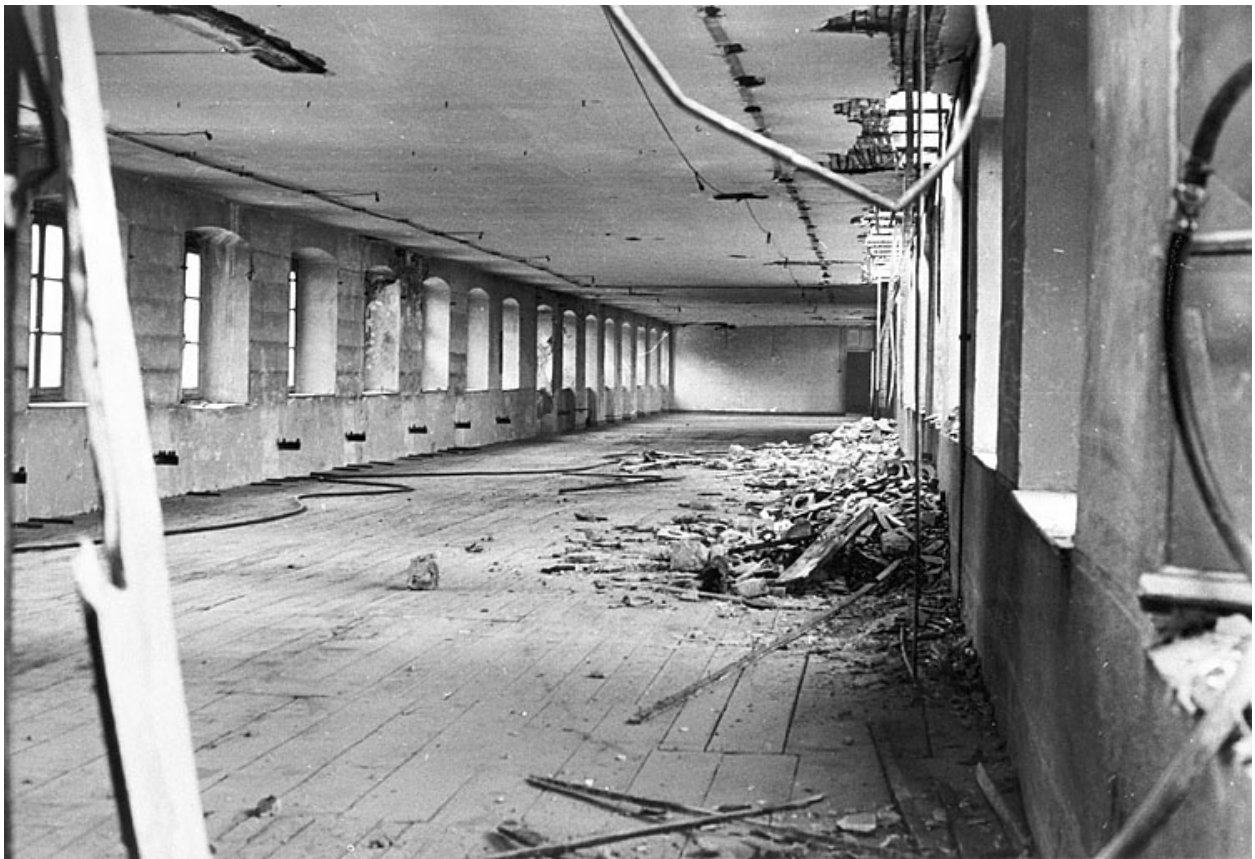
Atelier au second étage (état en 1978).
