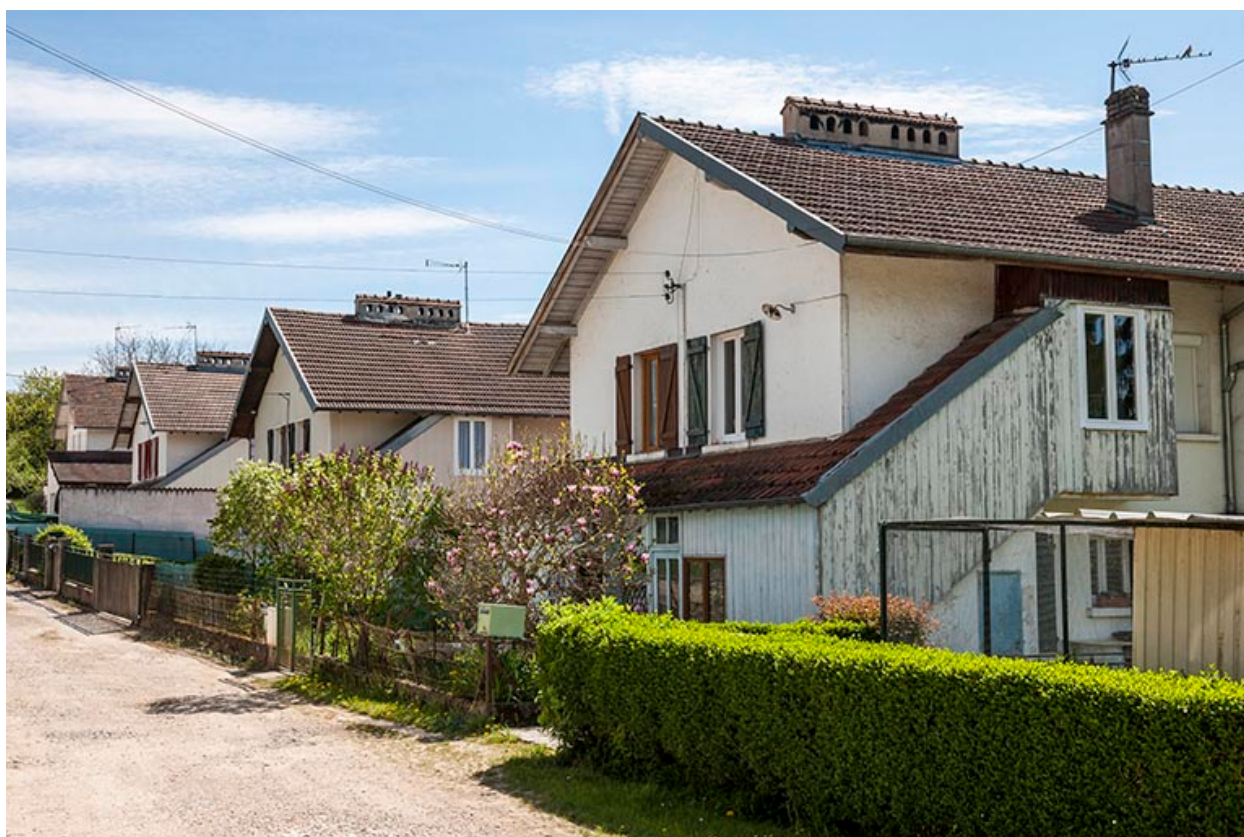
Maisons jumelées (rue des Cités).
