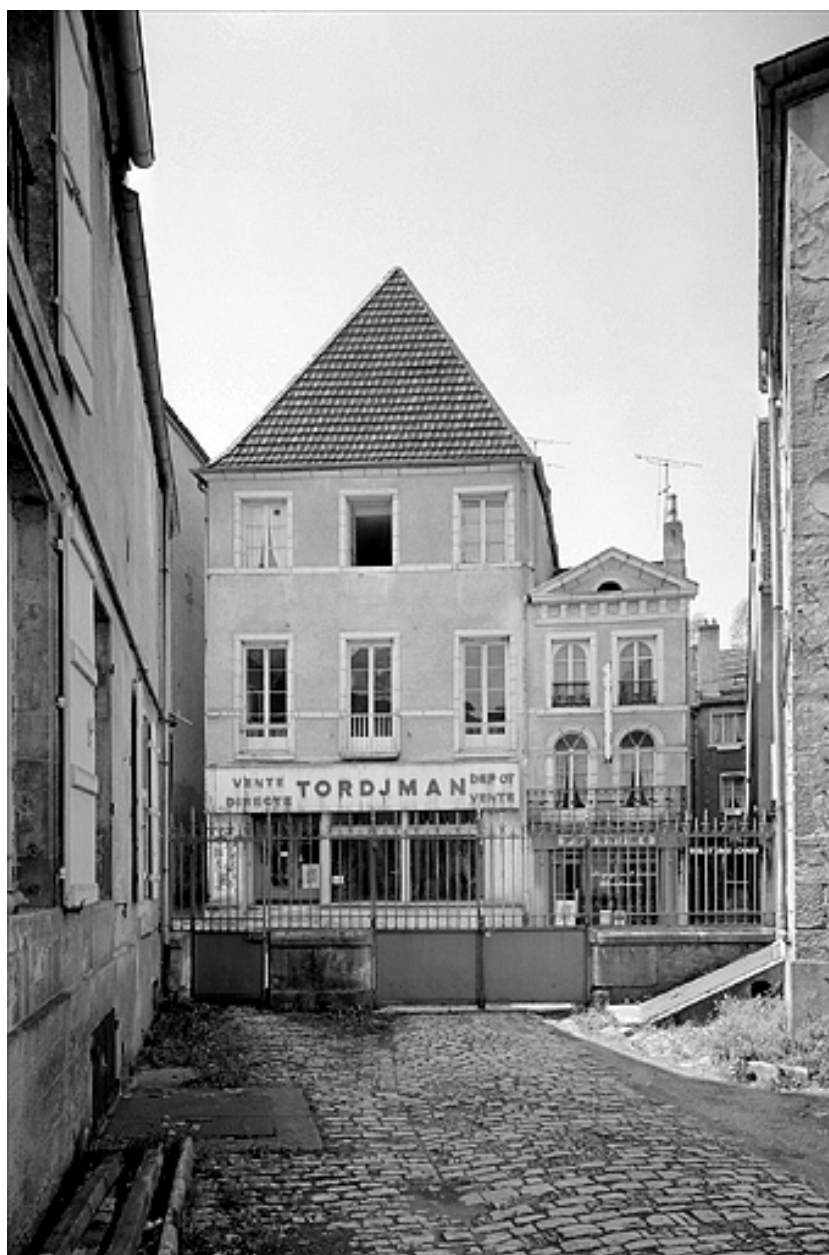
Façade antérieure de face.
