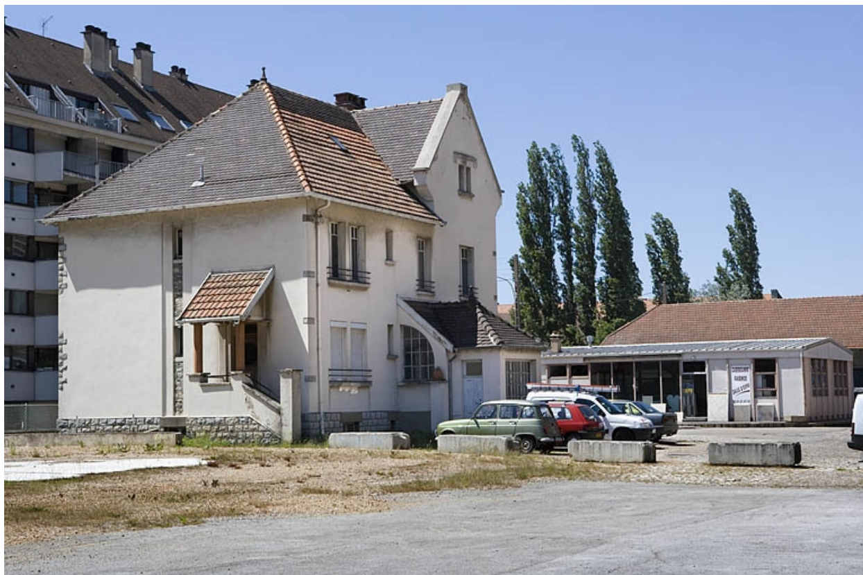
Bureau : façade postérieure de trois quarts gauche.
