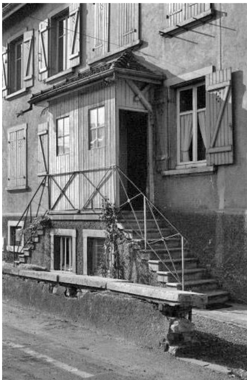
Détail de l'élévation antérieure.
