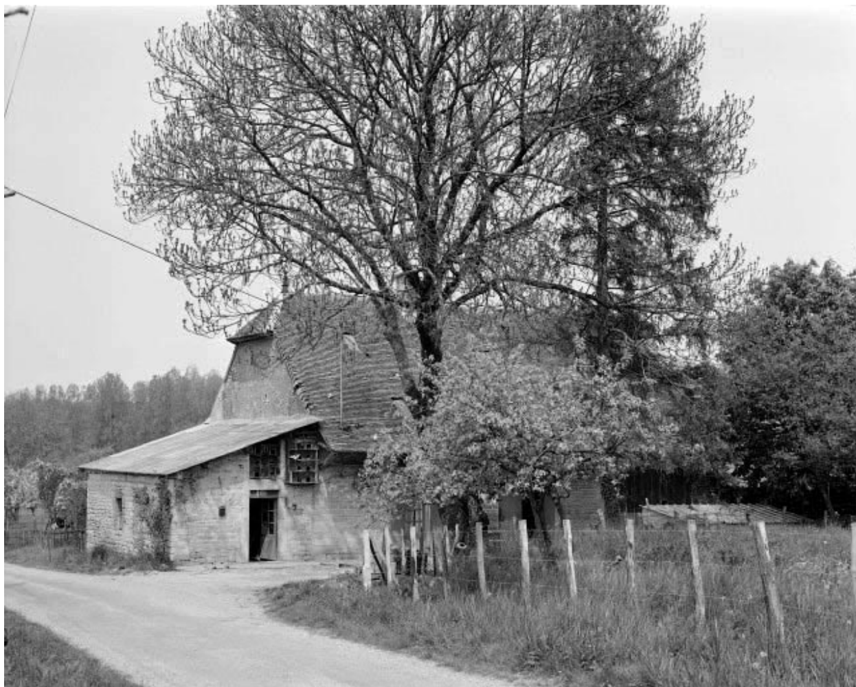
Ferme située 32 rue des Maquisards : vue d'ensemble.
