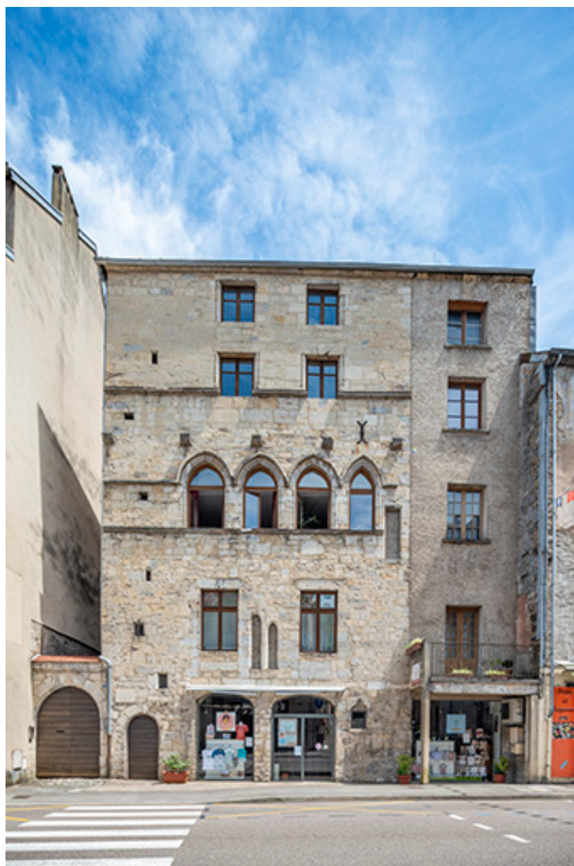
Façade antérieure. Vue de face.
