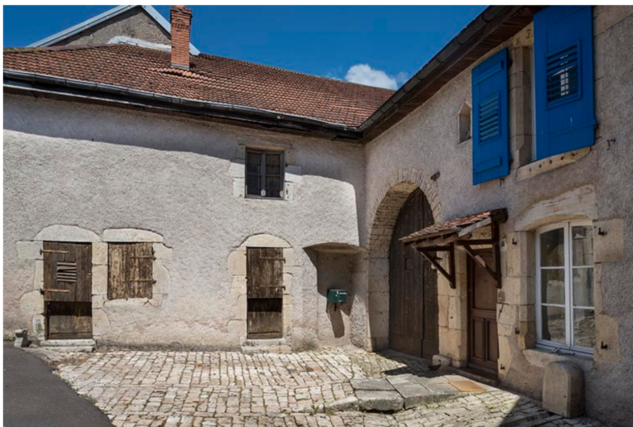
Façade antérieure, partie nord.
