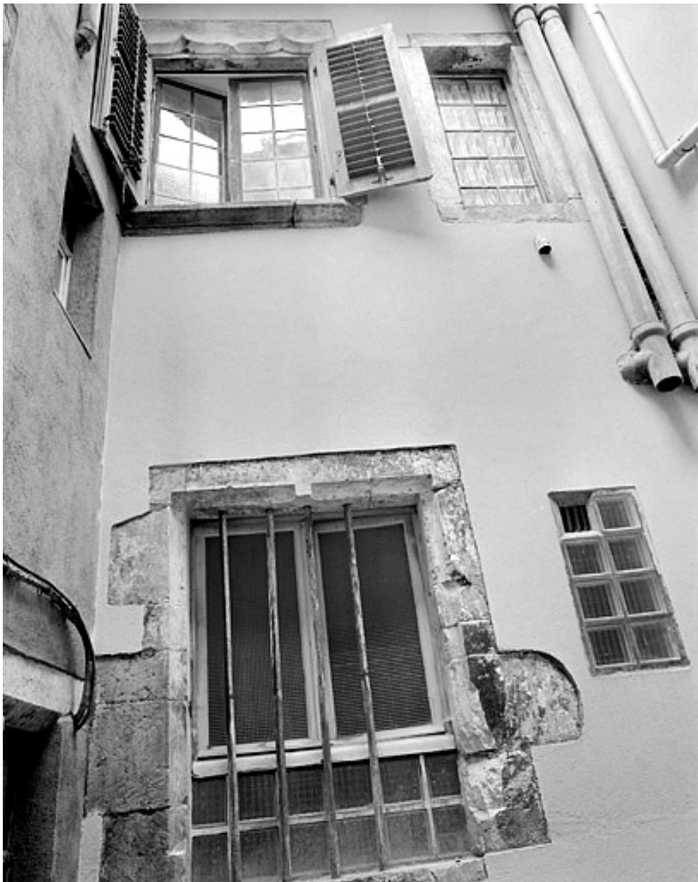
Façade du corps de bâtiment principal donnant sur la cour de la maison 27, rue des Febvres.
