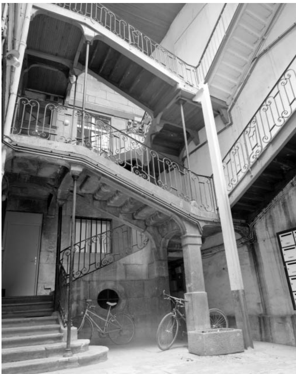
Vue d'ensemble de l'escalier à cage ouverte.
