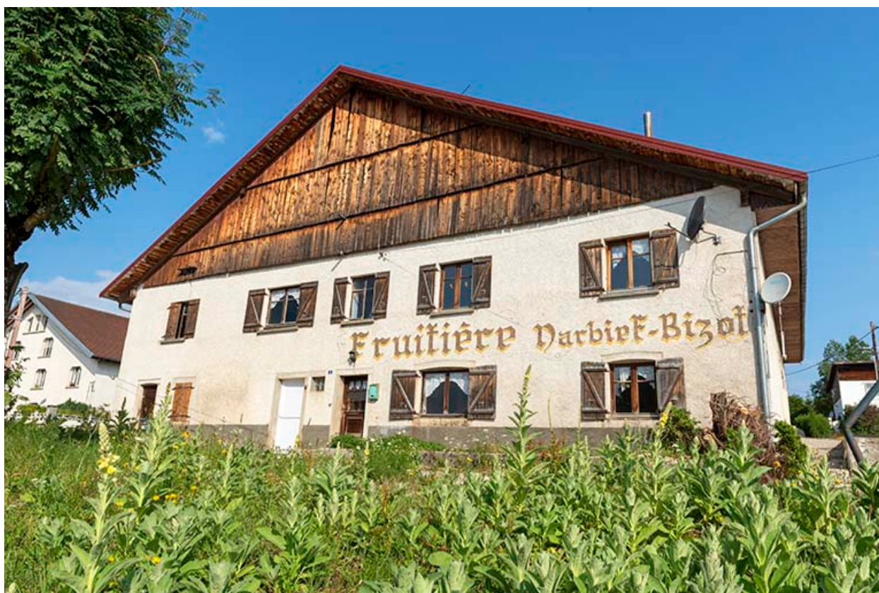
Façade antérieure, vue en contre-plongée.
