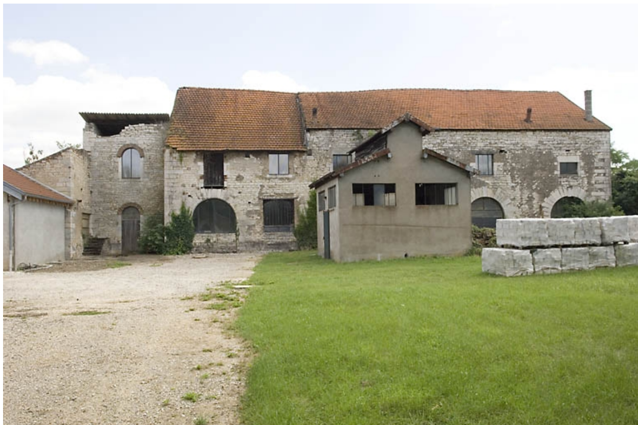
Façade nord du haut fourneau ouest.
