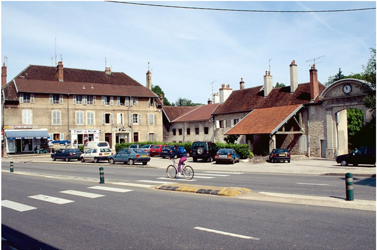
Logements d'ouvriers, bureau et portail.
