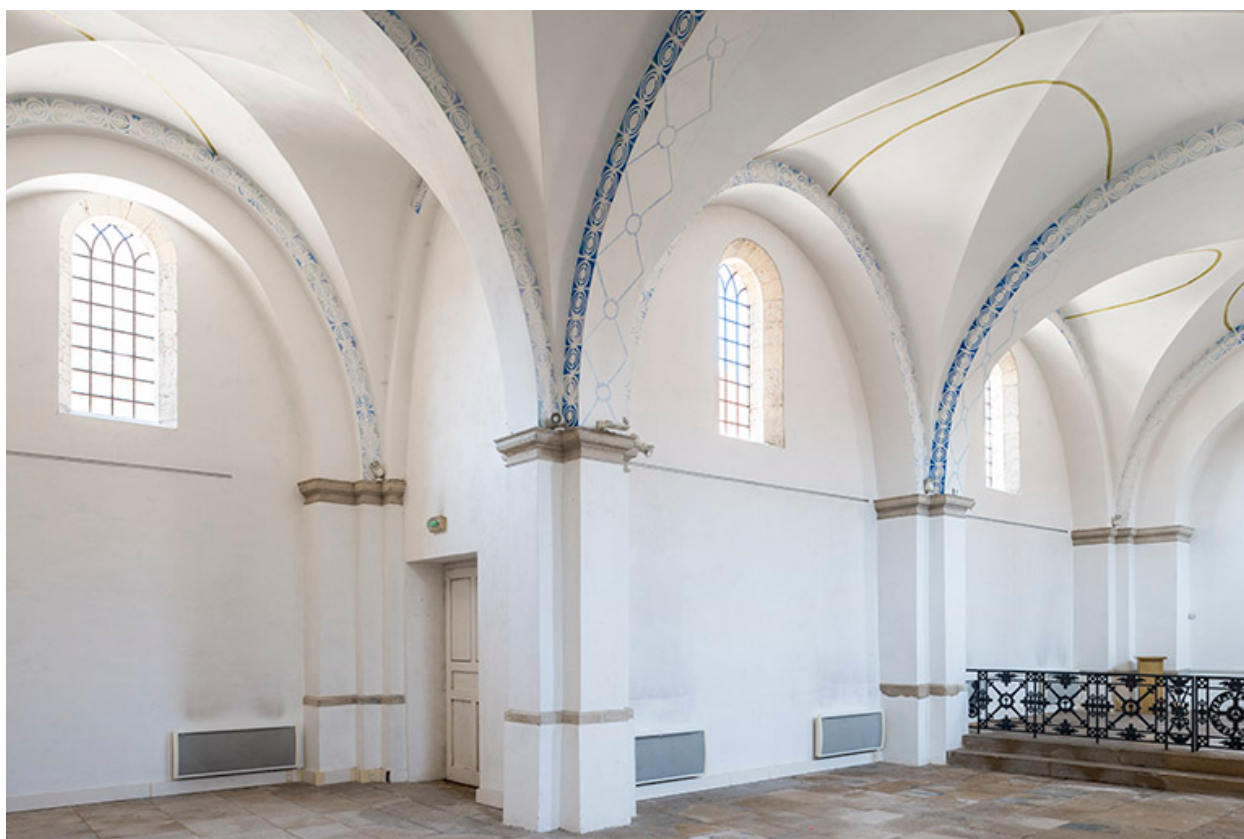
Le mur ouest de la nef.
