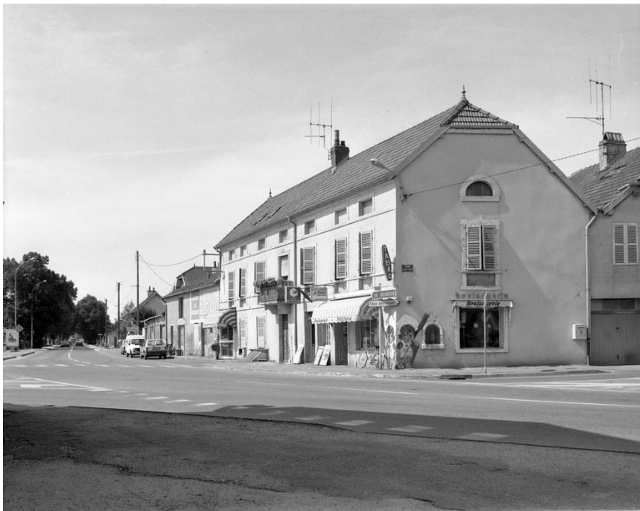
Façades antérieures et latérale droite.
