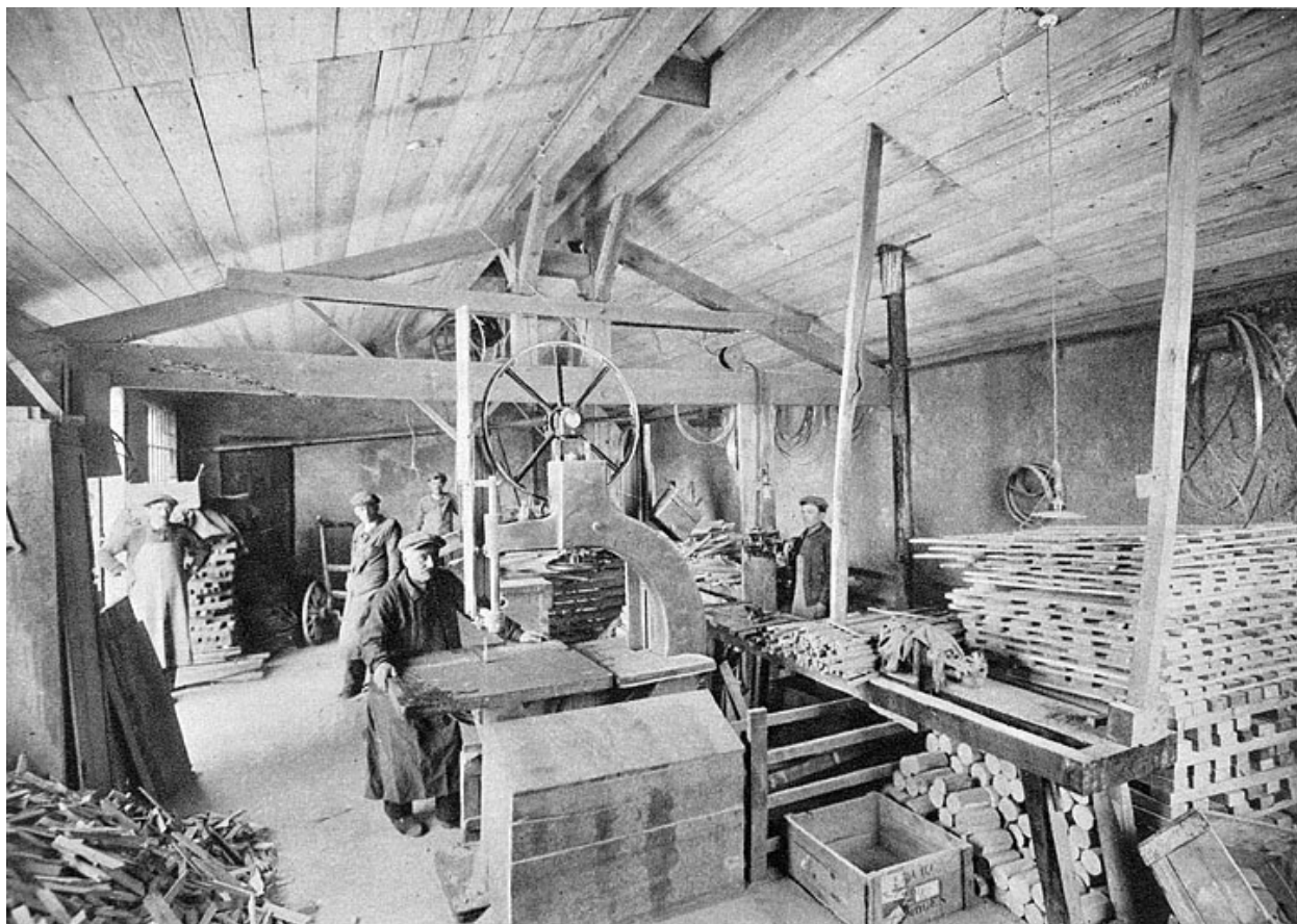
Usine de tabletterie (tournerie) de la coopérative la Tournerie ouvrière, Lavans-lès-Saint-Claude (8 rue de la Cueilie) : La Tournerie ouvrière (détaillage des bois), Société coopérative à Lavans-les-St-Claude, début des années 1920.
