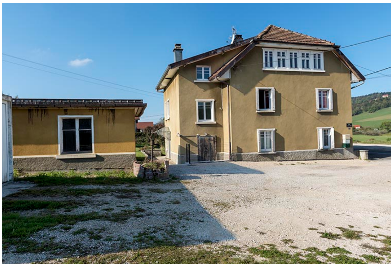
Garage et façade latérale gauche.
