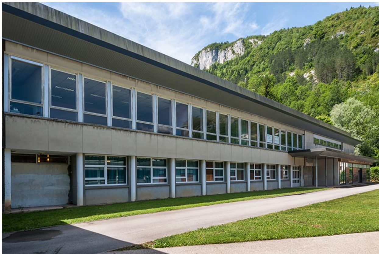
Atelier : façade est.
