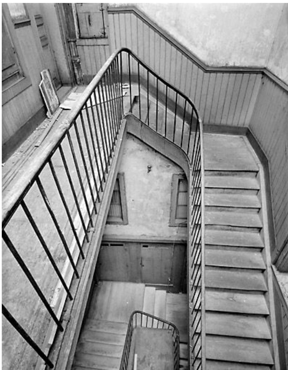
Vue plongeante sur la cage d'escalier.
