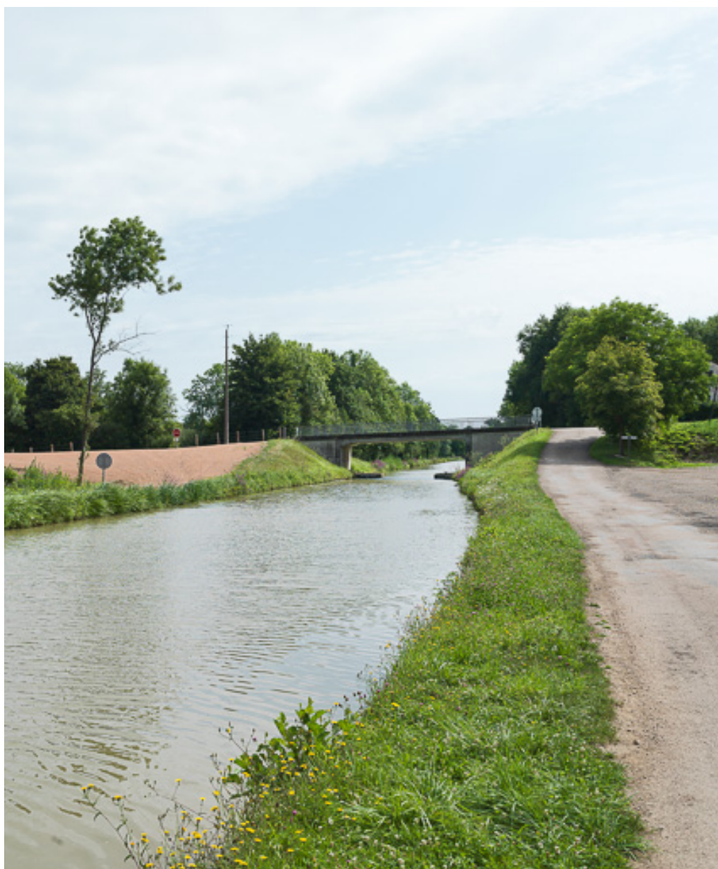
Vue d'ensemble du pont et du site.
