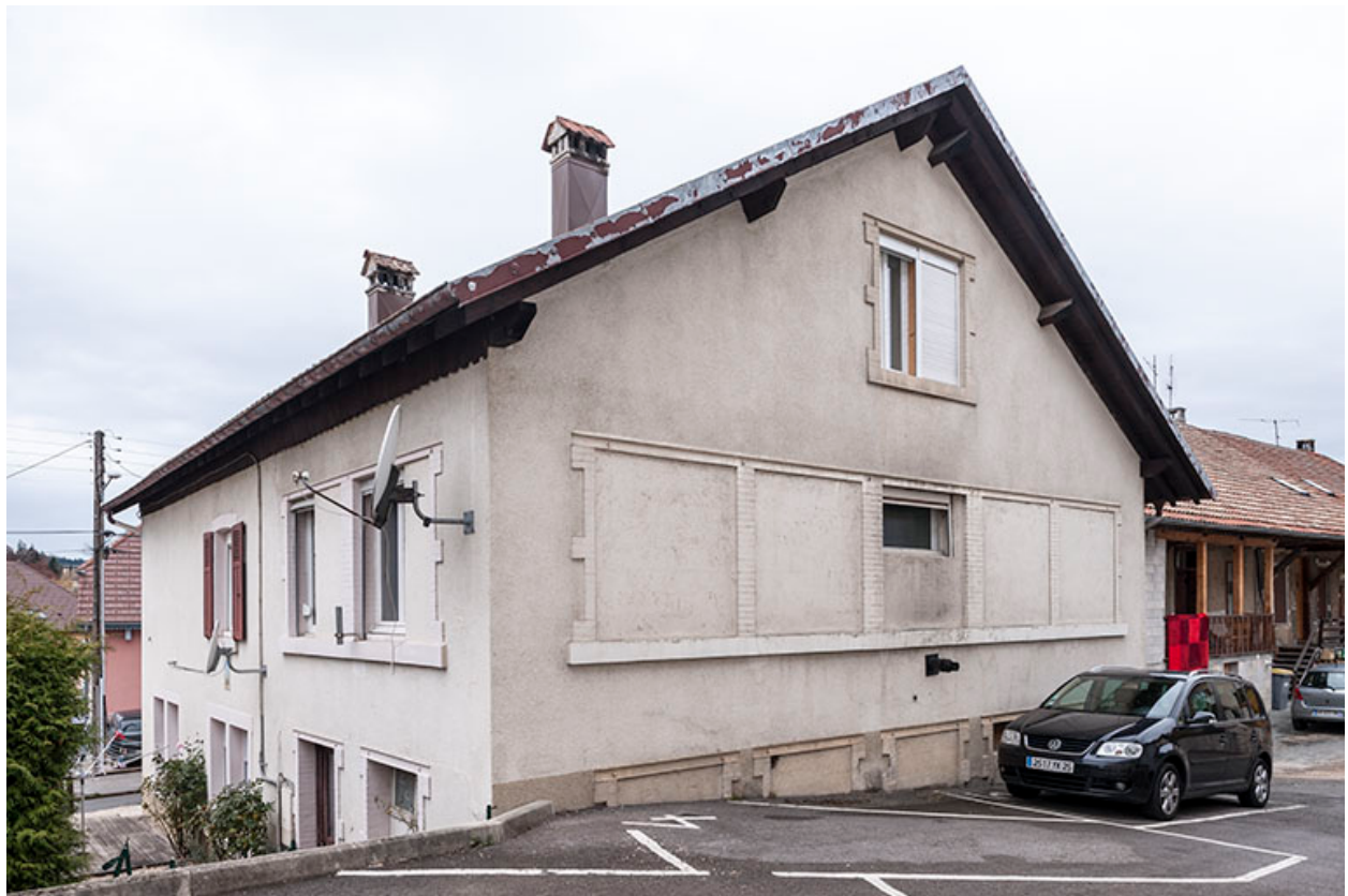
Maison : façades postérieure et latérale droite.
