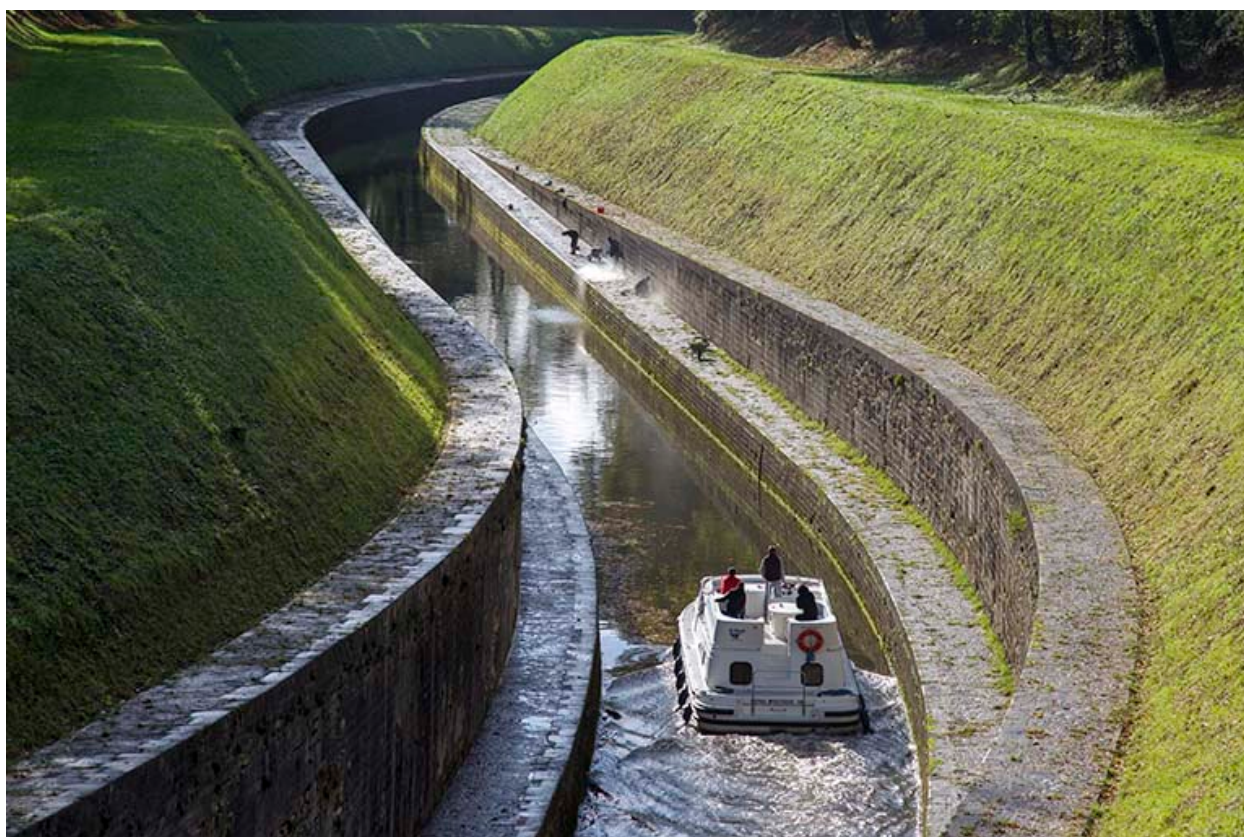
Le canal en aval de la dérivation souterraine de Saint-Albin (Haute-Saône).
