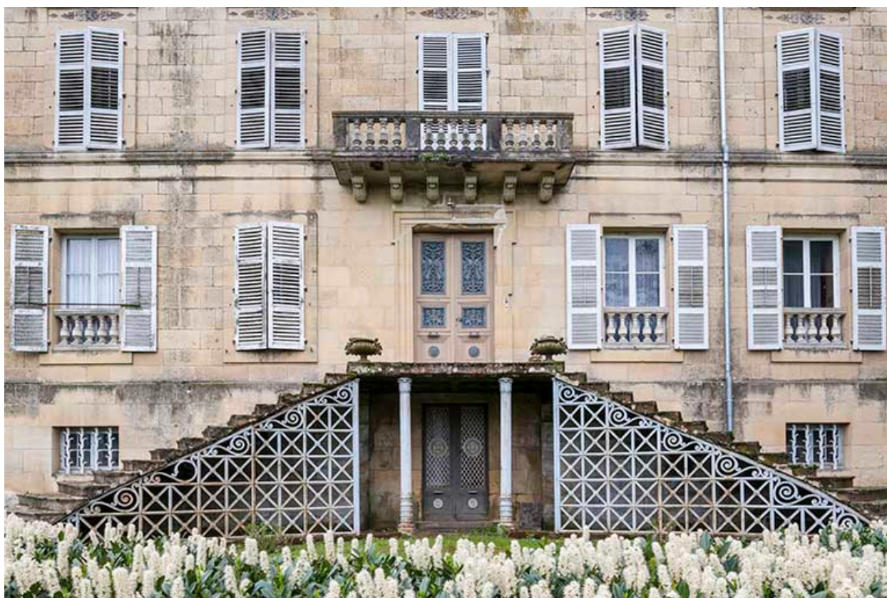
Vue générale, façade nord.
