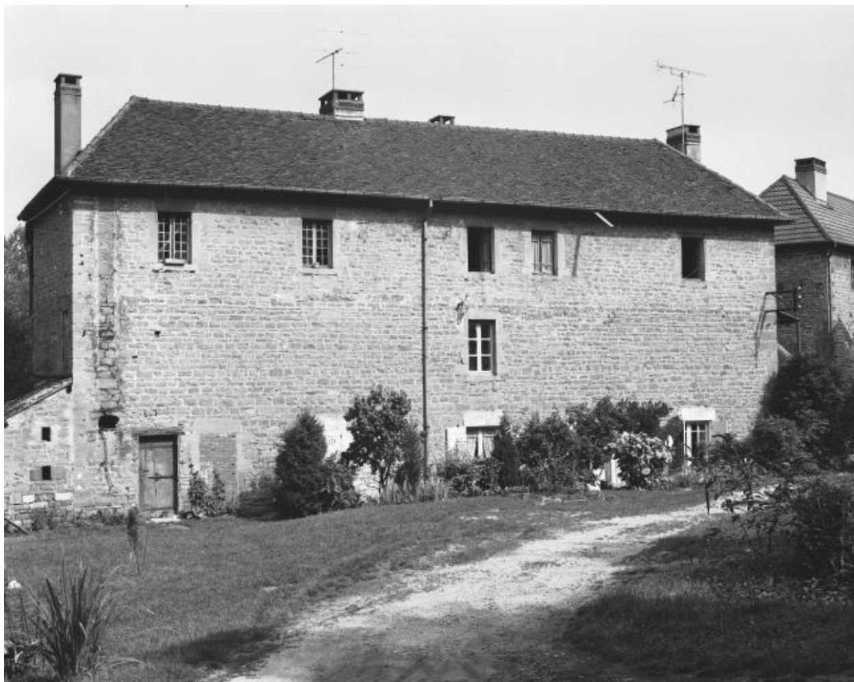
Façade antérieure d'un logement ouvrier.
