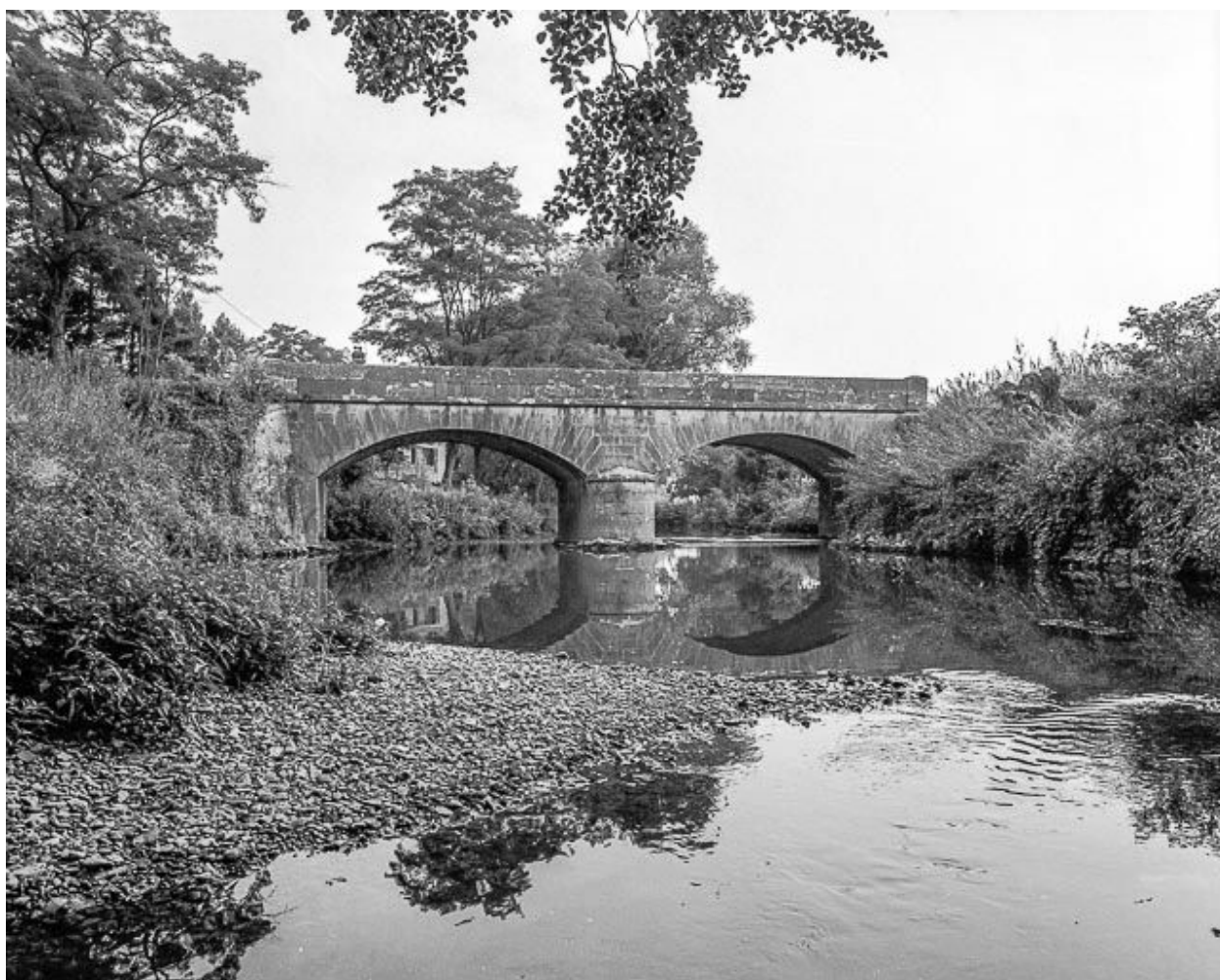
Condamine : pont sur la Vallière.
