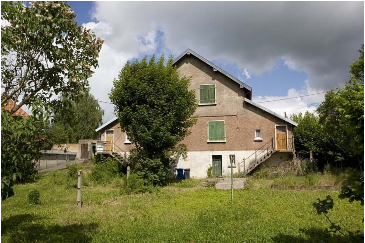
Cité Lehmann. Façade postérieure d'une maison.
