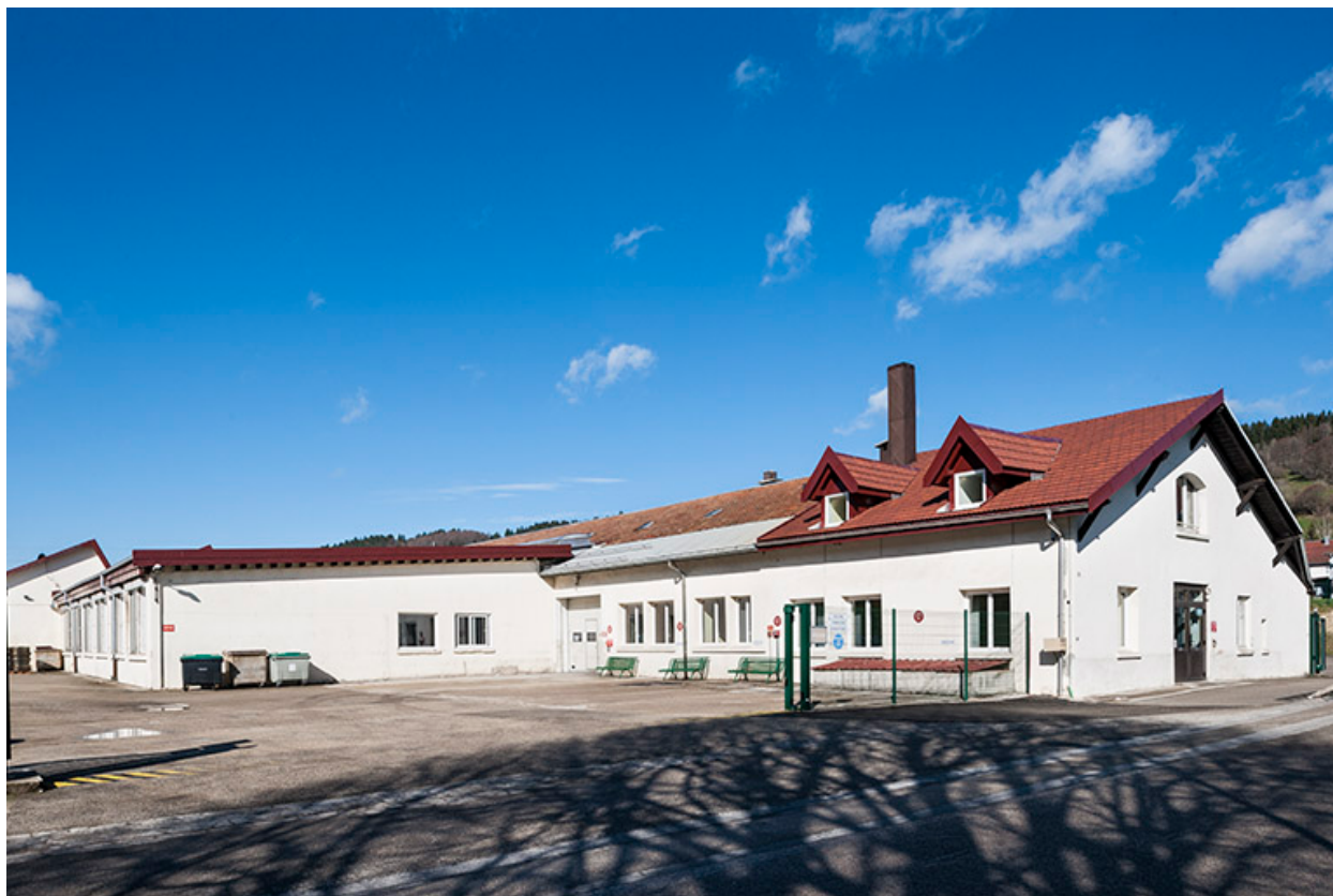
Usine originelle et extension, depuis l'est.
