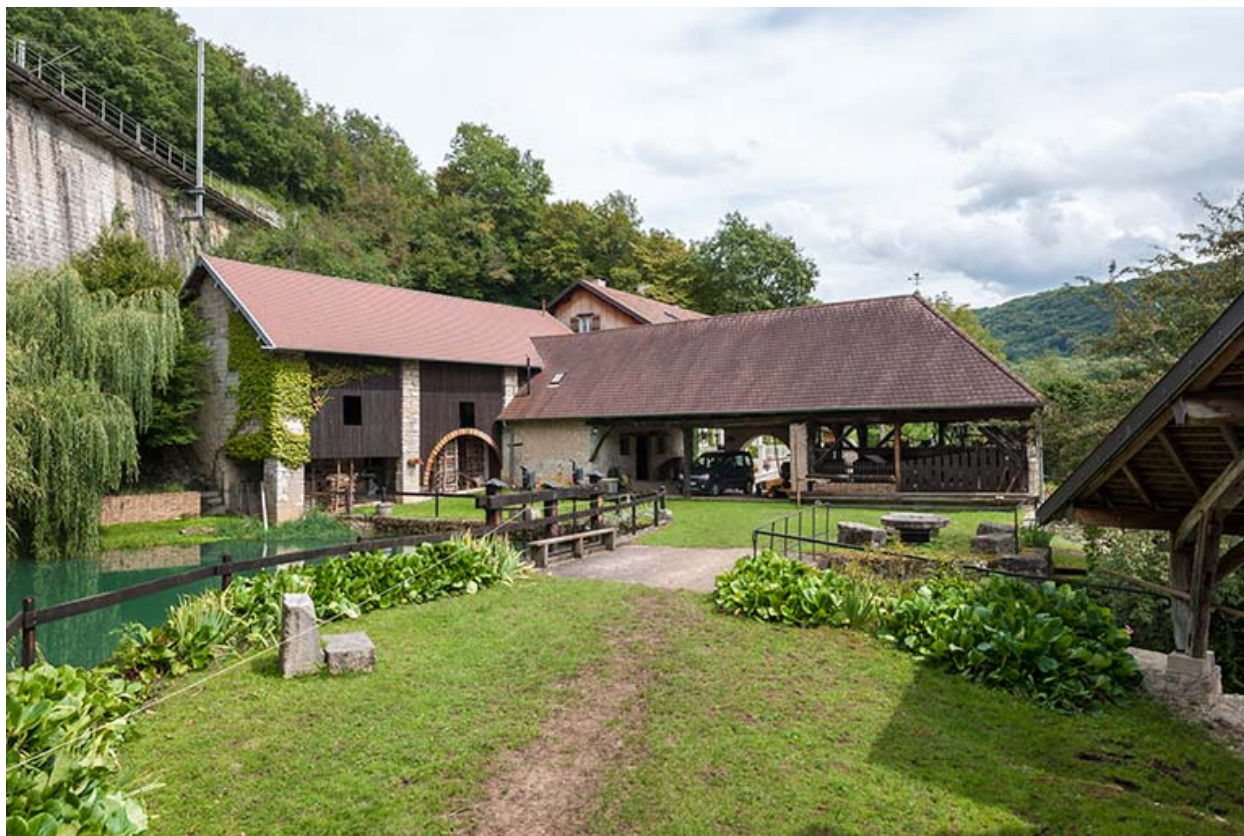
Grange, écurie et remise depuis l'ouest.
