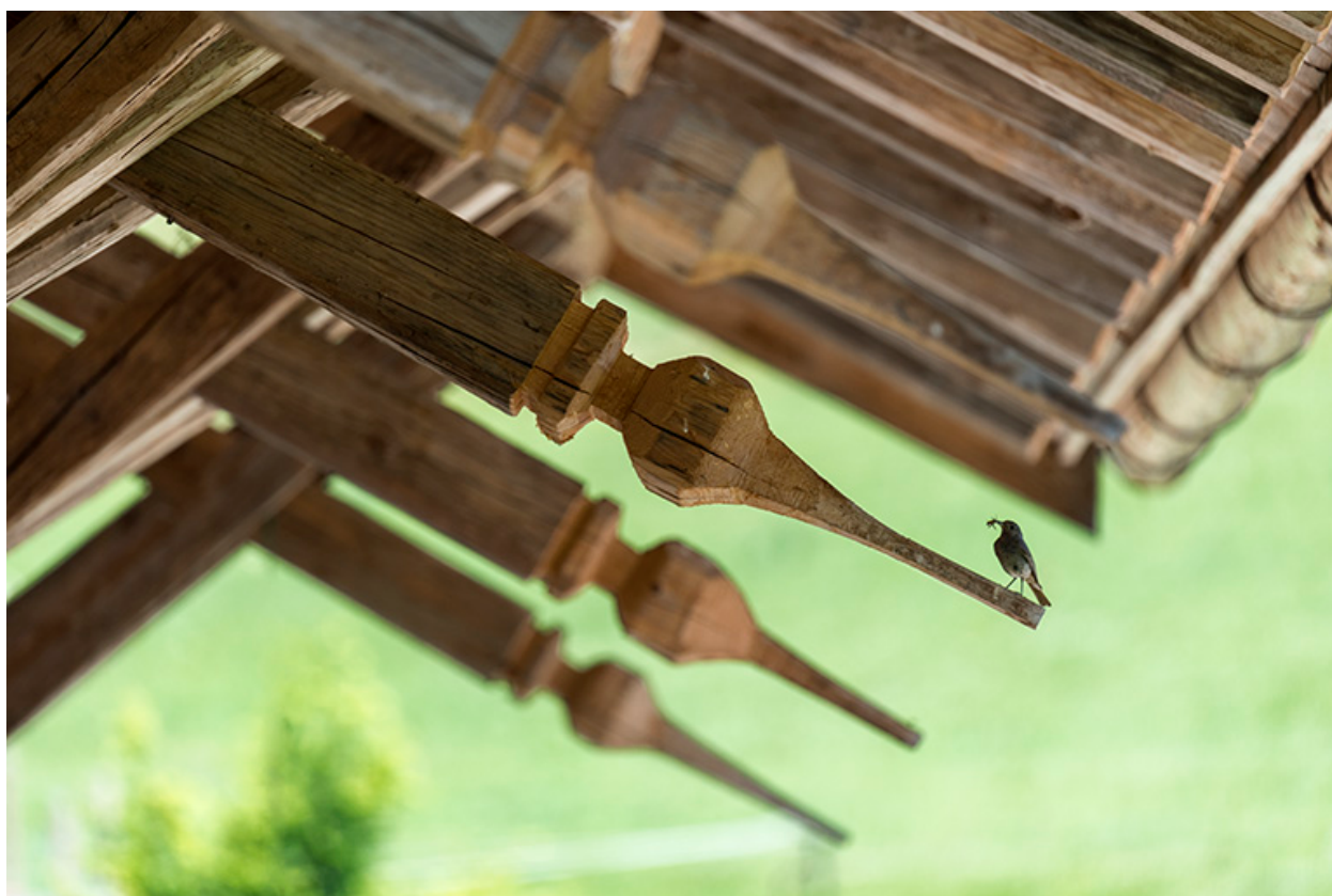
Extrémité sculptée des arbalétriers (façade antérieure).
