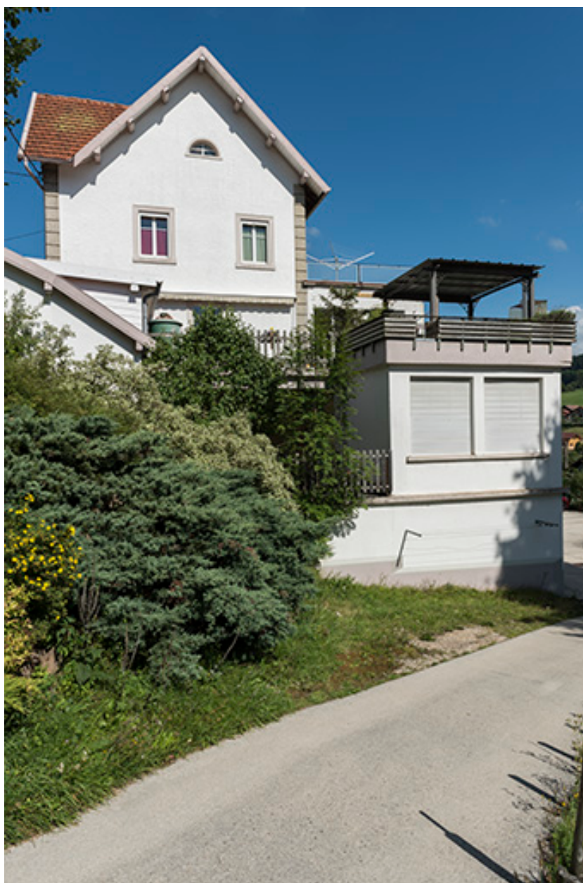
Usine : façade latérale droite.
