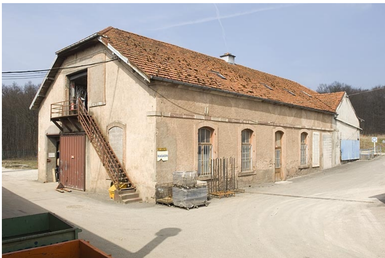
Moulin d'aval. Vue de trois quarts.
