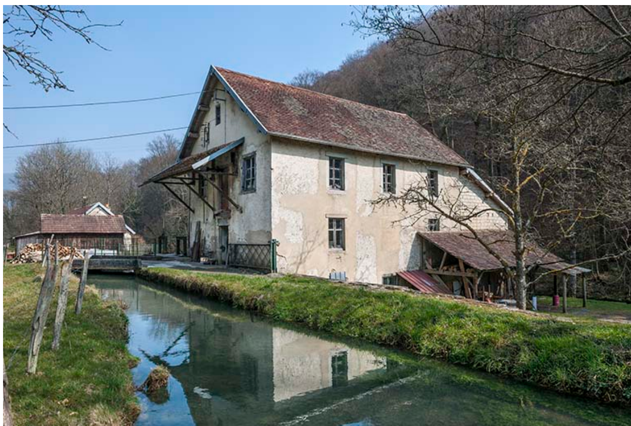
Le moulin et son canal d'amenée.
