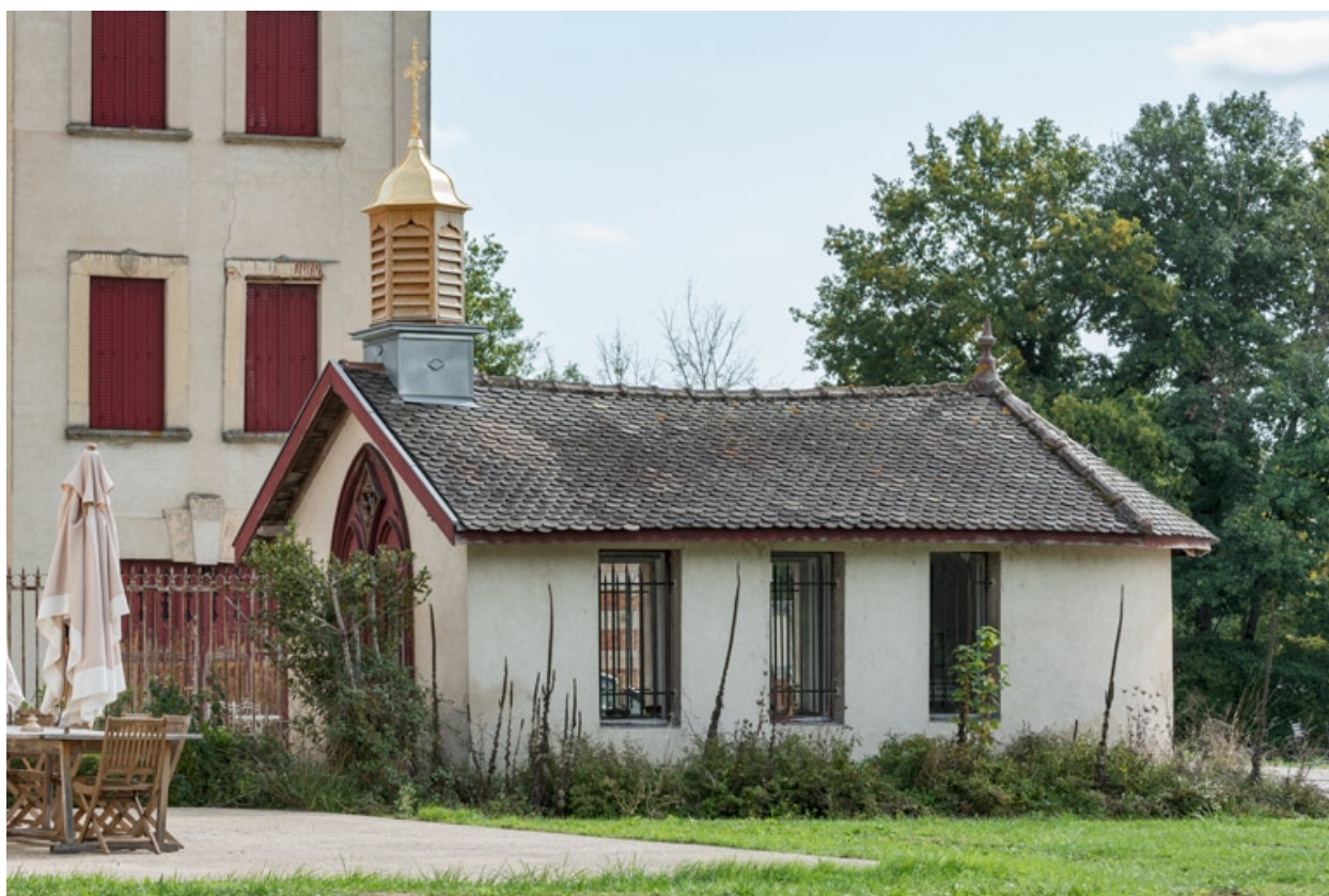
Chapelle : élévation latérale droite (ouest).
