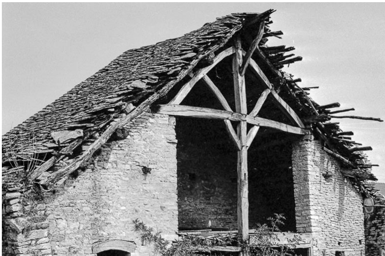
Ferme cadastrée B3 256 : toiture.
