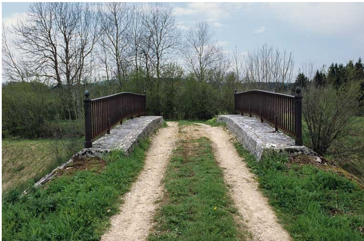
Vue d'ensemble du tablier.
