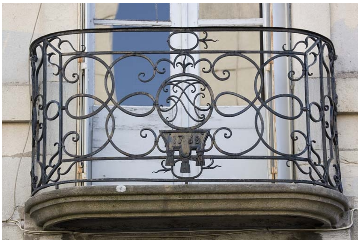
Détail du balcon : vue rapprochée.
