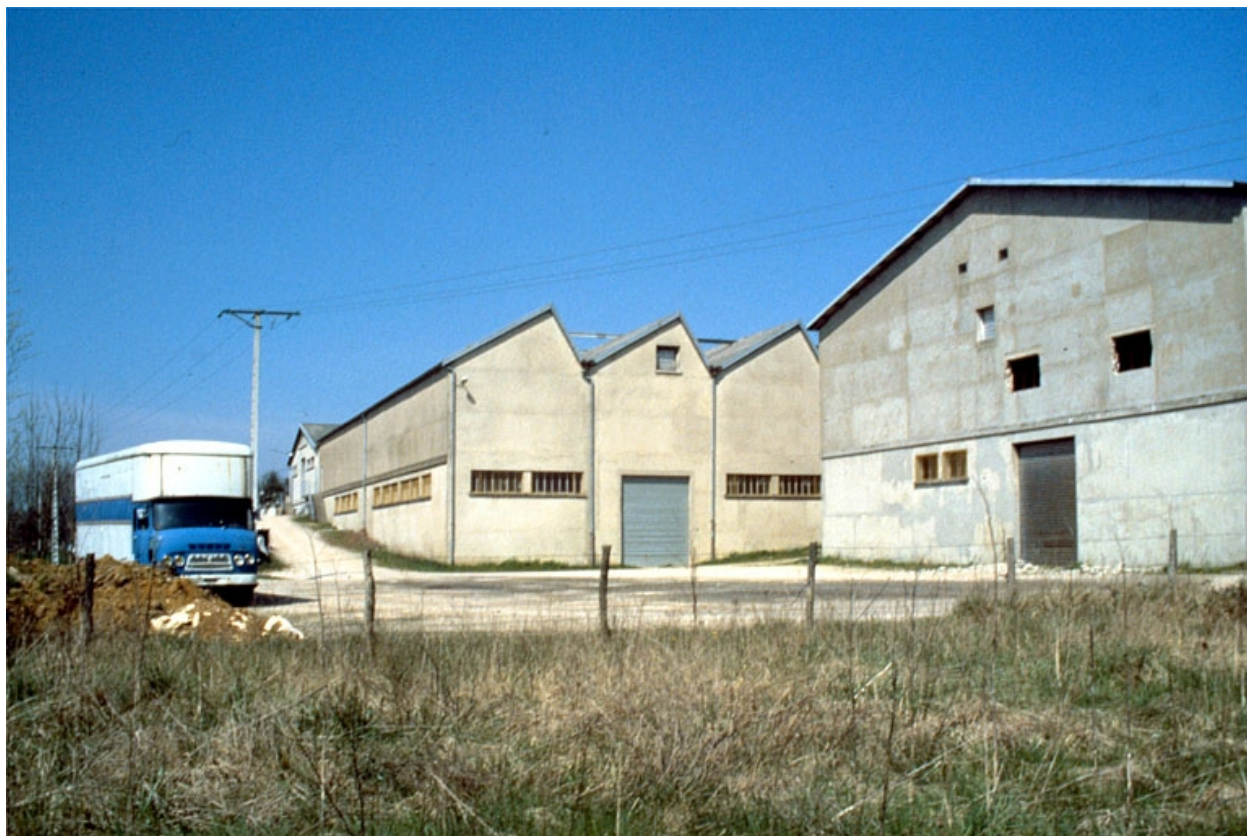
Façade postérieure du tissage et de la filature.
