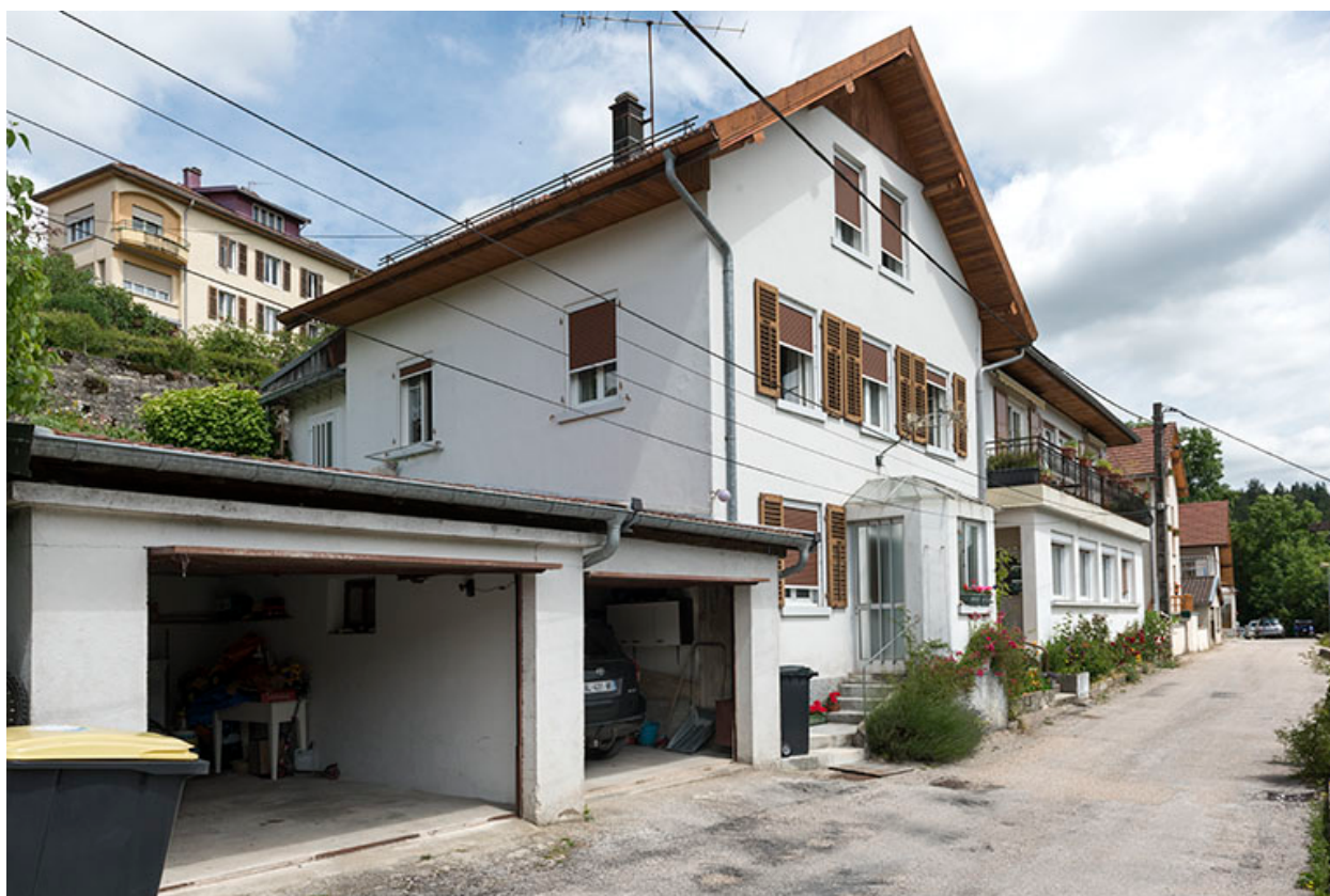
Façades antérieure et latérale gauche.
