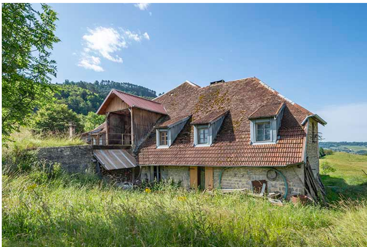
Vue depuis le nord.
