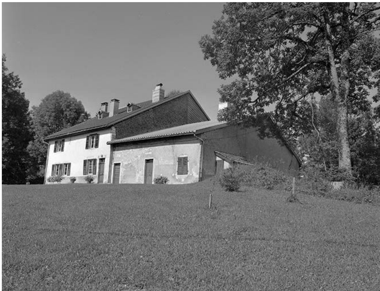
Ferme située au lieudit Les Petits Valets.
