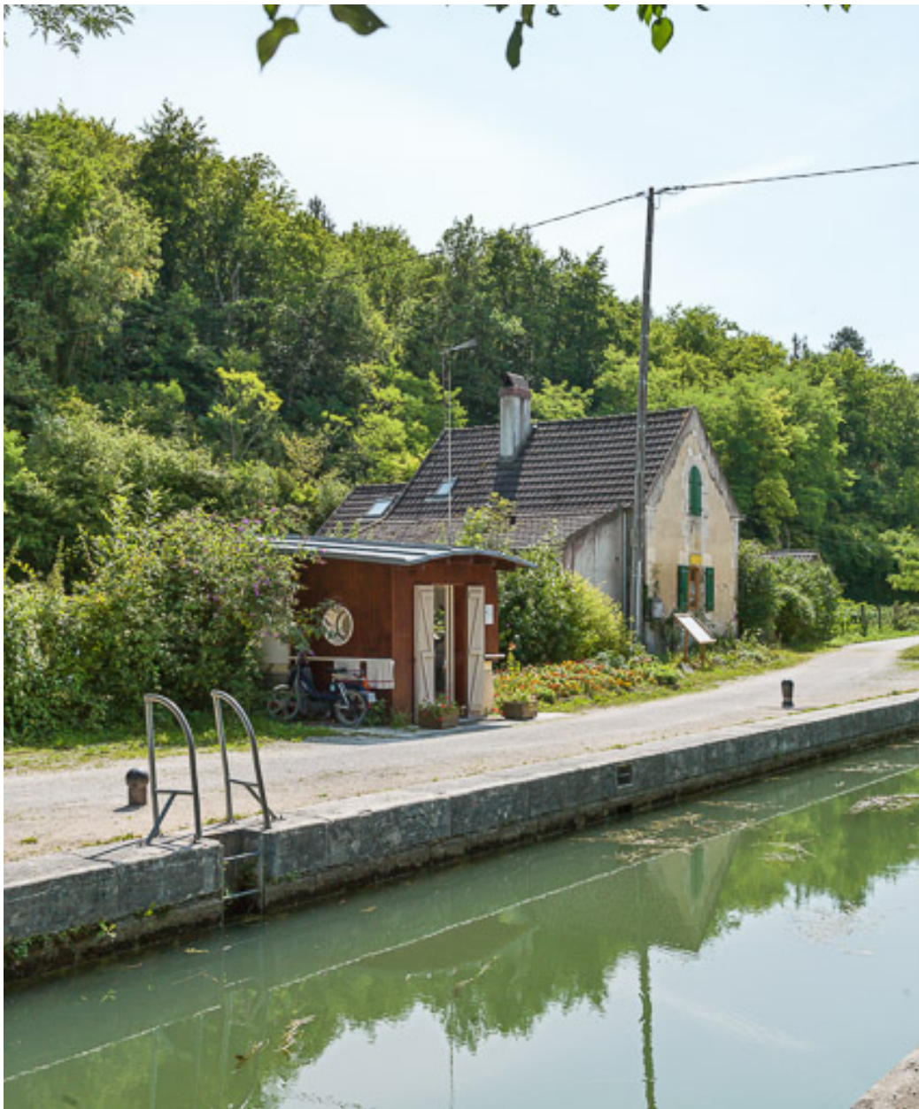
Vue de la maison éclusière et de la guérite.
