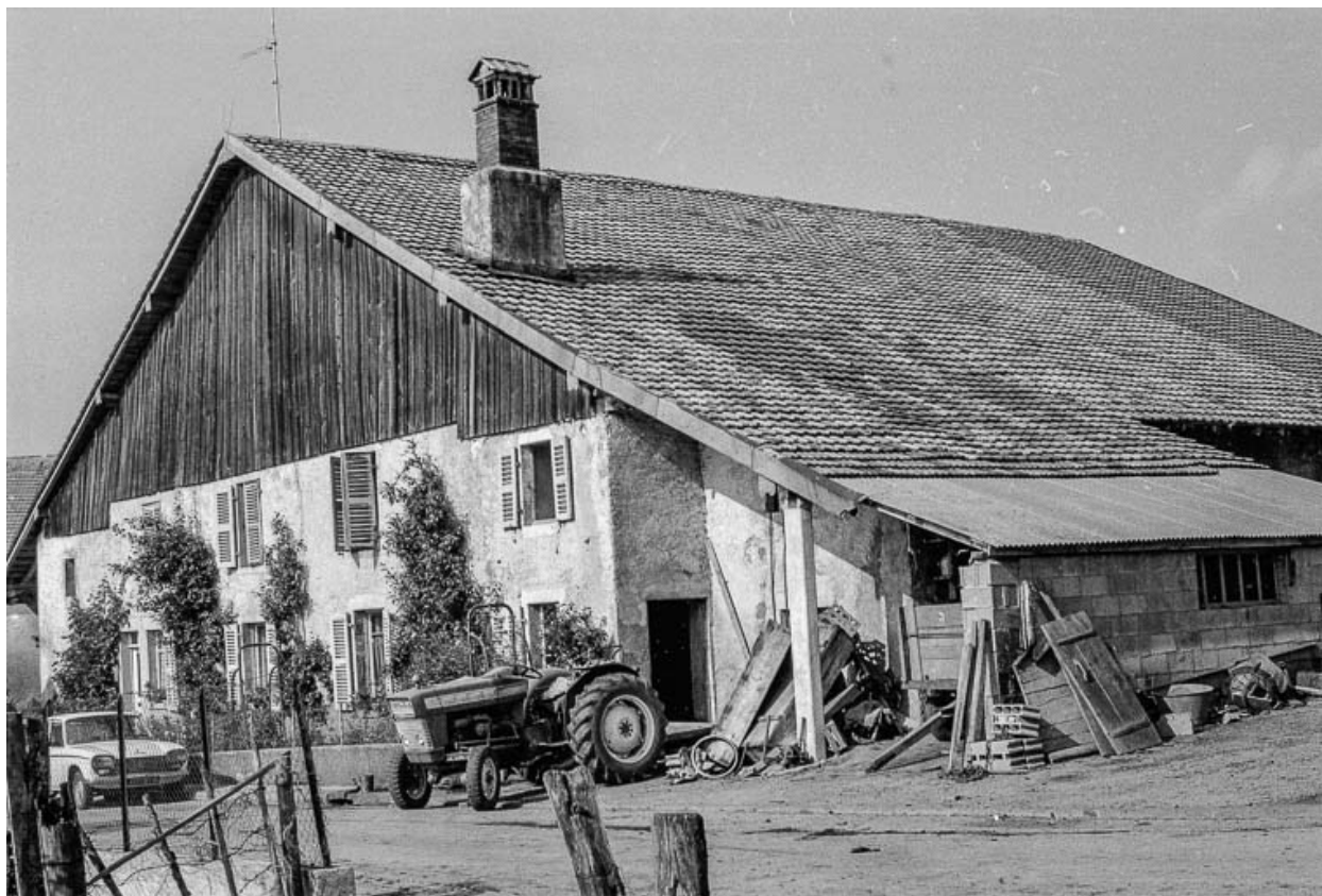
Pignon d'habitation et gouttereau postérieur.
