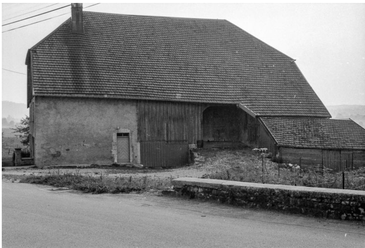
Façade latérale droite.
