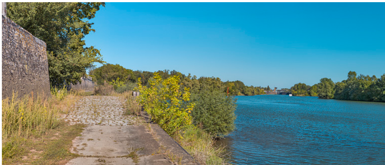
Pavage et ponceau sur la rive droite.
