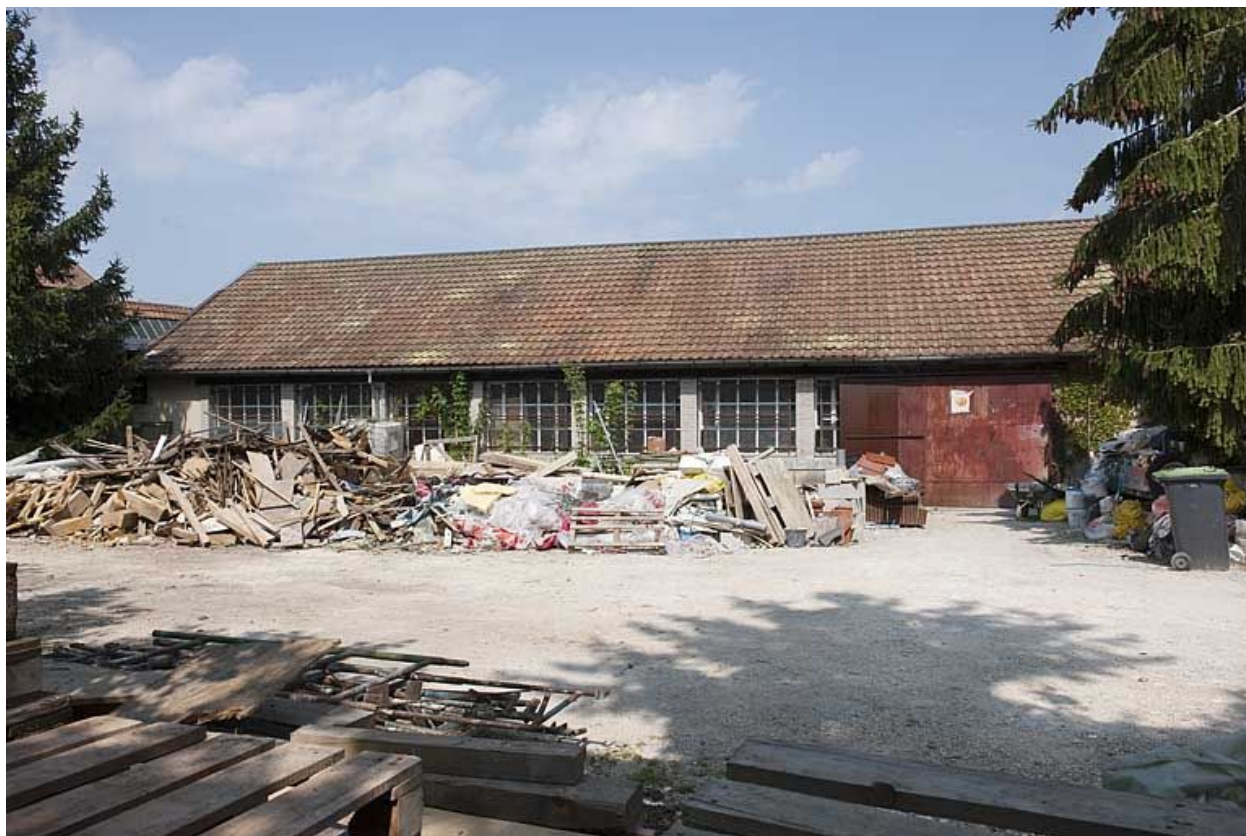
Façade sud de l'atelier de fabrication.
