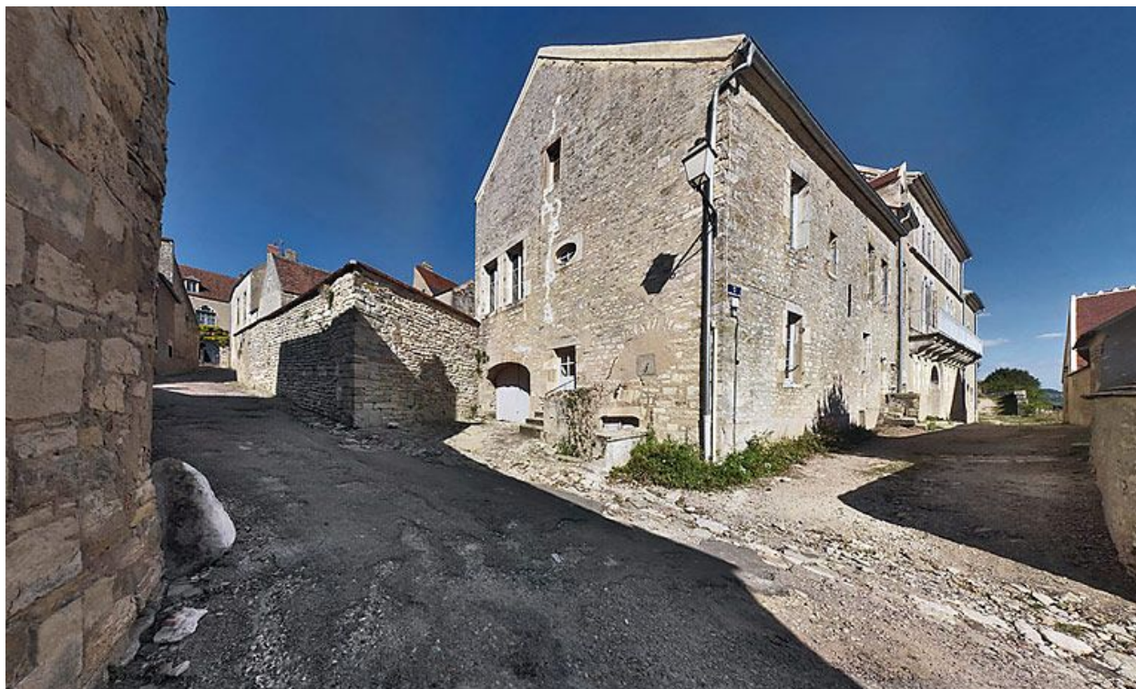
Vue d'ensemble des façades postérieures.
