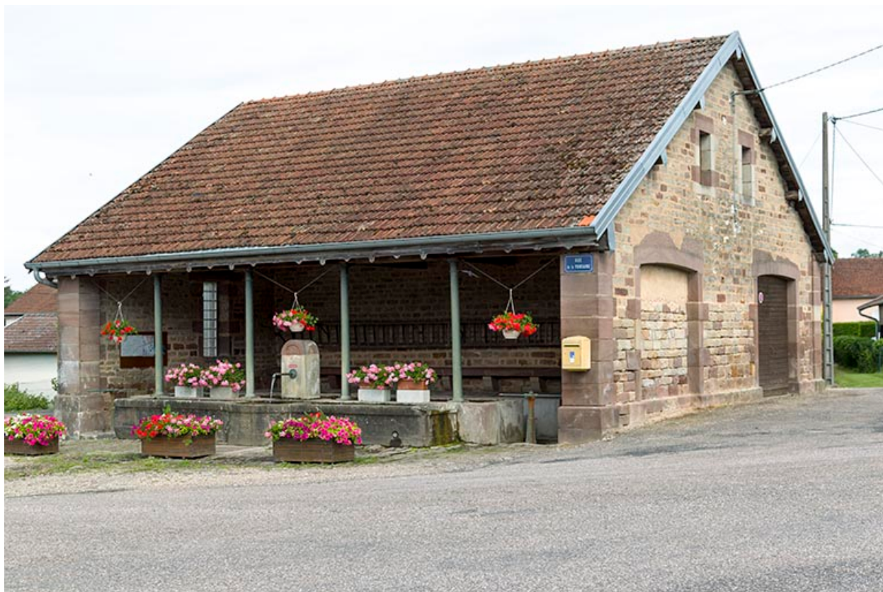
Fontaine-lavoir, rue de la Fontaine.
