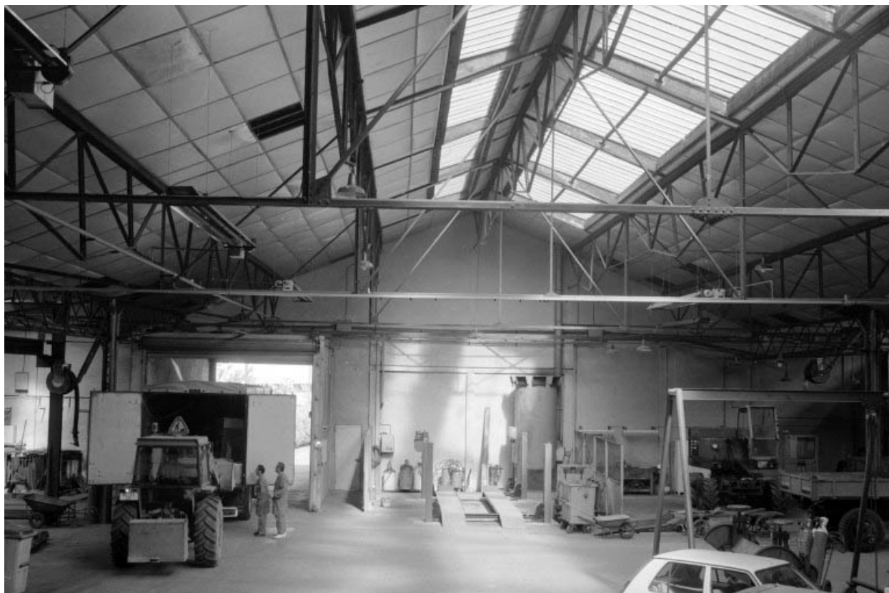
Intérieur de l'atelier de fabrication.
