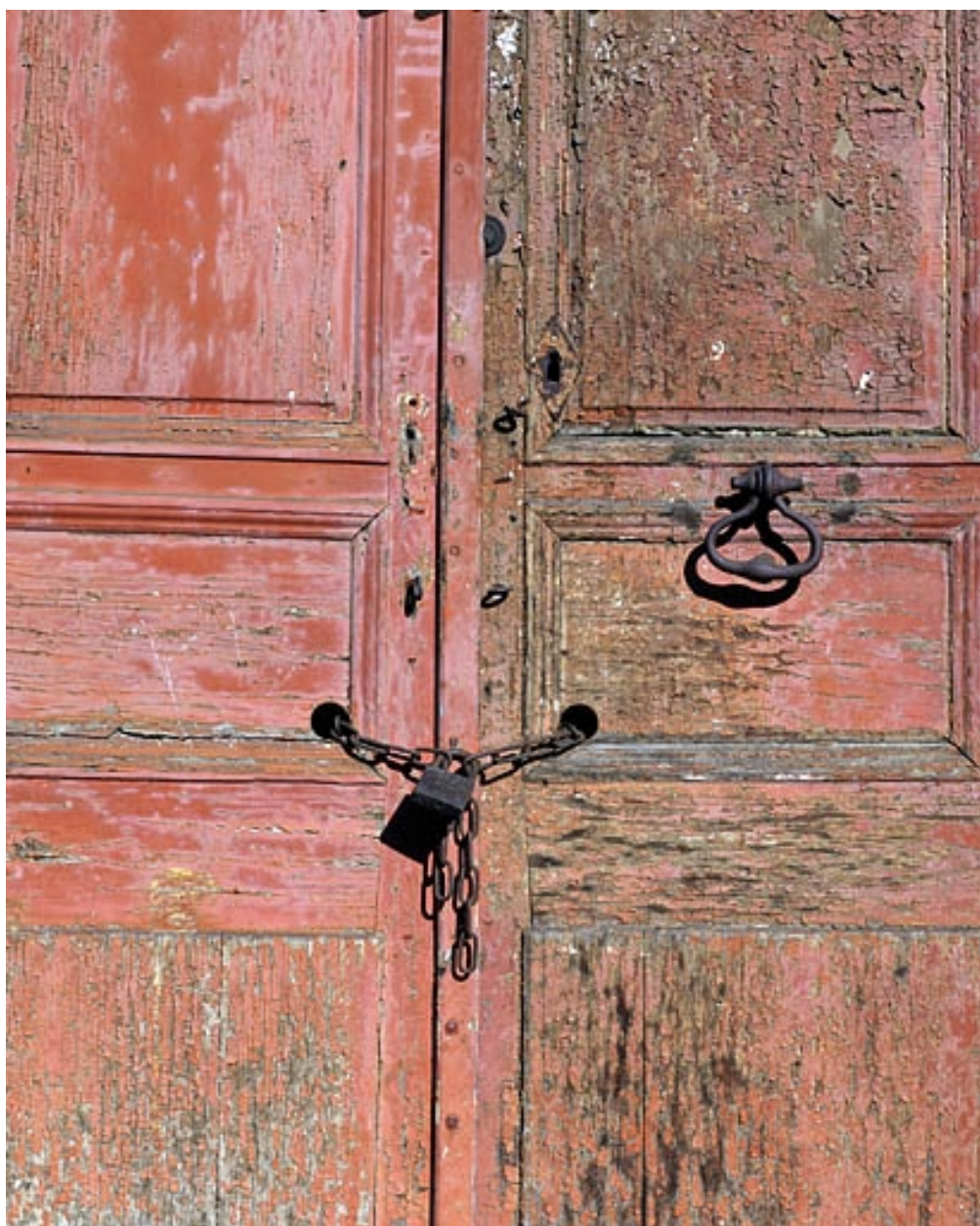
Entrée principale : détail des vantaux.
