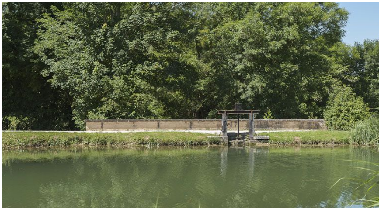
Déversoir rive gauche.
